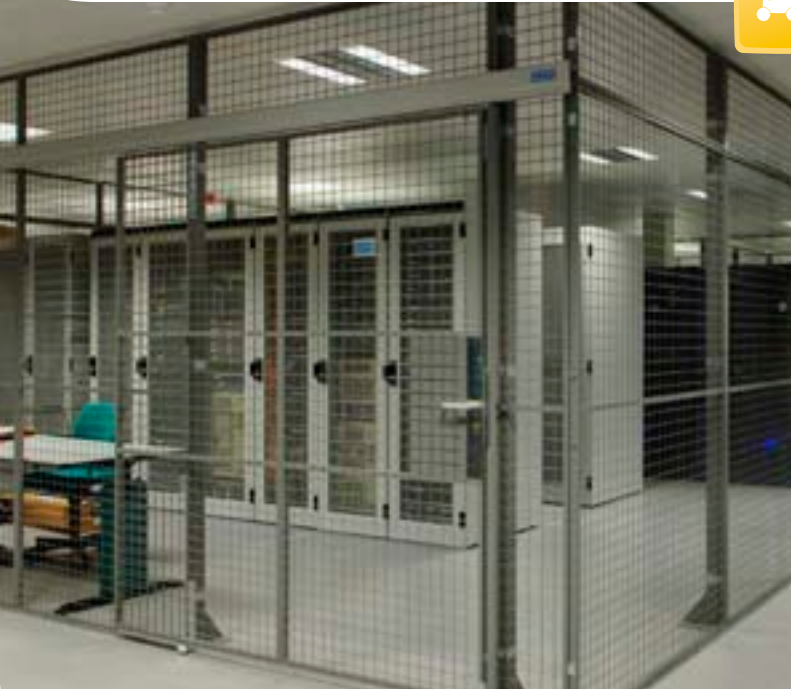
Bild oben: In einem Serverraum bieten Troax-Trennwände nicht nur Einbruchschutz, sondern auch Transparenz und optimale Belüftung. Bild unten: Lagerbereich eines Supermarkts
