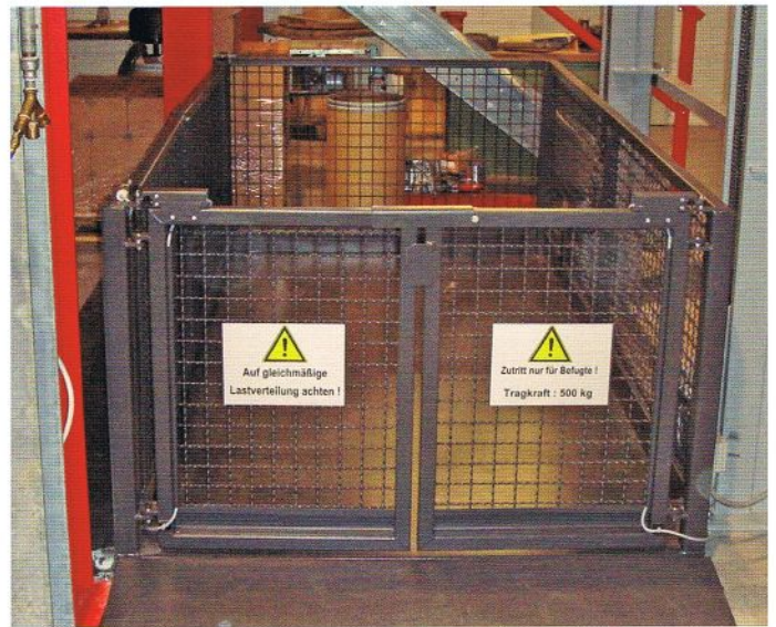
Zweiflügelige Doppel-Drehtür am Förderkorb, auf der schmalen Korbseite angeordnet
